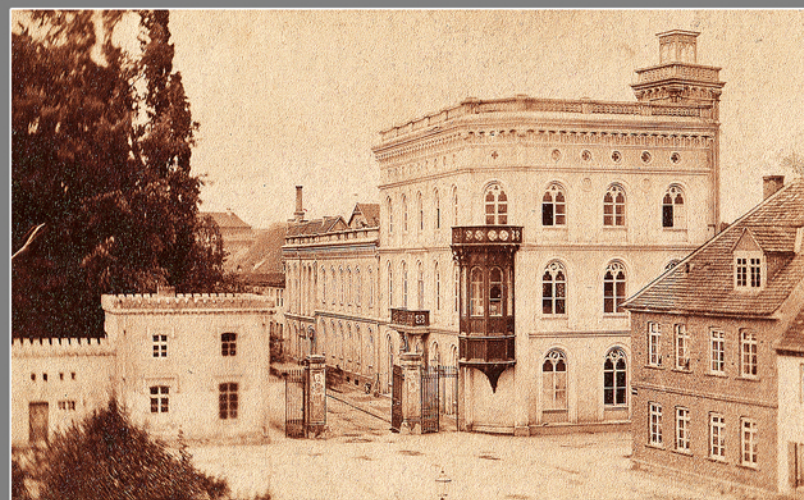
Die Lutzsche Klinik (1855 eröffnet) zu Lebzeiten von Dr. Arthur Lutze mit dem Springtor und Wachlokal vor 1870. Tor und Wächterhaus wurde um dieses Jahr abgerissen. Die Bäume dahinter gehören schon zum Schlosspark
