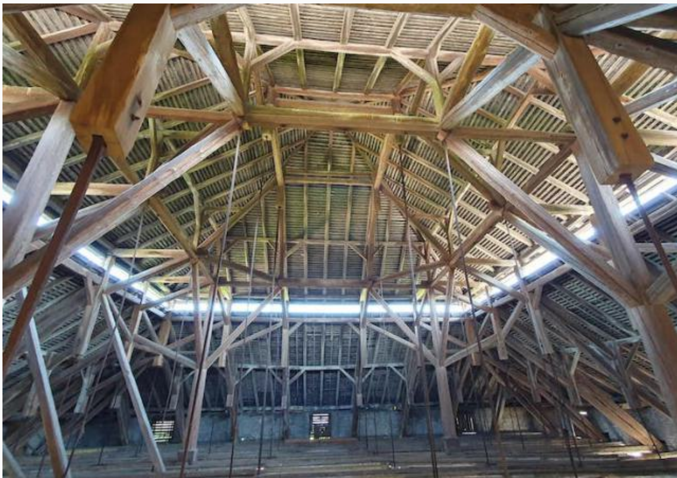
Ein Blick in die Konstruktion des historischen Dachstuhls.
