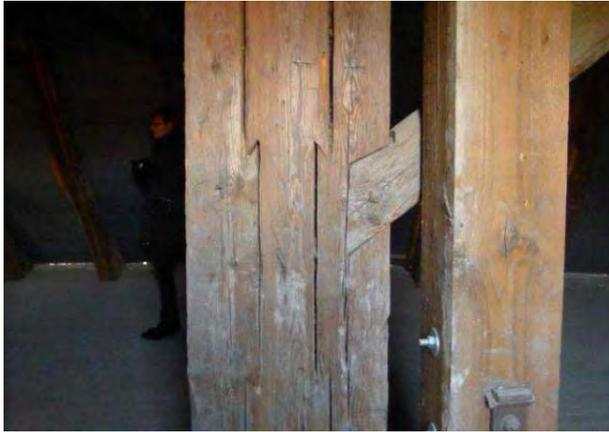
Mit einer solchen Schwalbenschwanz-Verbindung fingen Zimmerleute im 17. Jahrhundert Zugkräfte im Dachgebälk ab.
