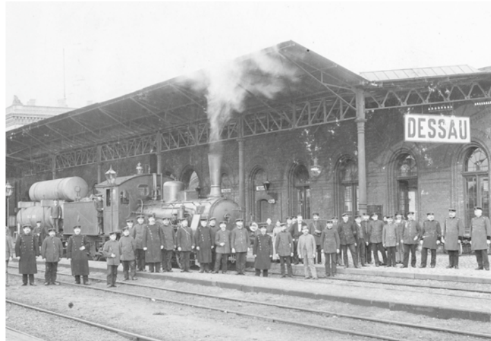
Blick auf den alten Dessauer Bahnhof, um 1920 Quelle: DB Fahrzeuginstandhaltung GmbH, Werk Dessau
